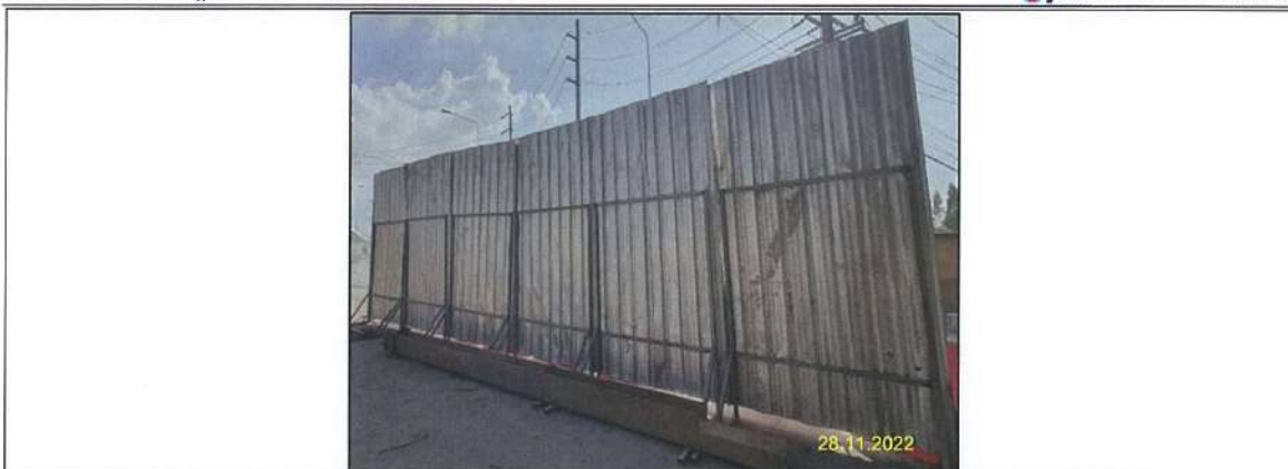
(5) พื้นที่ก่อสร้าง (บ่อรับ Boring2 และบ่อส่ง Boring3) บริเวณบ้านพักอาศัยหมู่ที่ 1 บ้านตลาดบางพูน รูปที่ 2-10 (ต่อ) การติดตั้งกำแพงกันเสียงชั่วคราว
