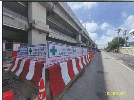
ง) ติดตั้งรั้วกำแพงคอนกรีต (ConcreteBarrier) รอบบ่อรับและบ่อส่ง พร้อมป้ายเตือนเขตหวงห้าม
