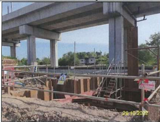
ค) อุปกรณ์ป้องกันการตกหลุมบริเวณปากหลุมรองขุด/บ่อรับ-บ่อส่ง และมีแสงสว่างอย่างเพียงพอ และไฟกระพริบในเวลากลางคืน
