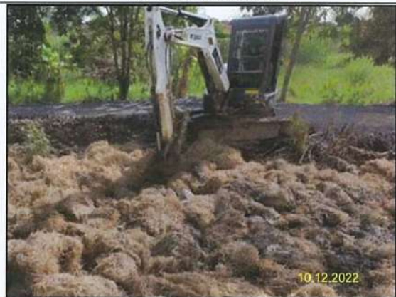
ญ) การผสมสารโซเดียมเบนโทไนท์ที่เหลือนิ่งกับดินธรรมชาติ หรือวัสดุธรรมชาติ บริเวณพื้นที่ตั้งโคลนโซเดียมเบนโทไนท์ของโครงการ
