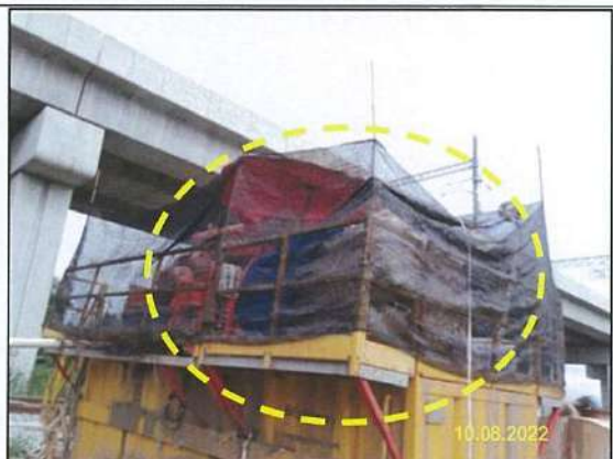
ฏ) กันพื้นที่ในขณะผสมโซเดียมเบนโทไนท์ (เครื่อง Recycle unit หรือเครื่องจักรใช้หมุนเปลี่ยนโซเดียมเบนโทไนท์)
