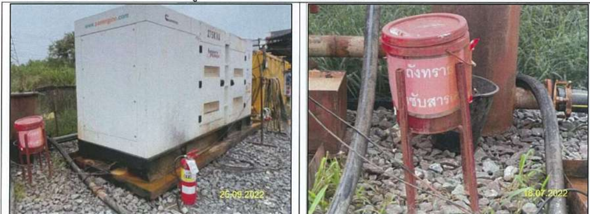
รูปที่ 2-15 การจัดเตรียมภาคเก็บรองรับน้ำมัน และวัสดุตุ้ดจับ
