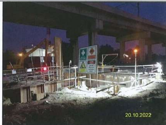
ค) อุปกรณ์ป้องกันการตกหลุมบริเวณปากหลุมรองขุด/บ่อรับ-บ่อส่ง และมีแสงสว่างอย่างเพียงพอ และไฟกระพริบในเวลากลางคืน
