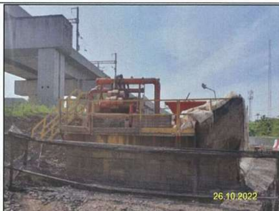
ง) การนำโซเดียมเบนโทไนท์มาใช้หมุนเวียนในระหว่าง การเจาะลอด
