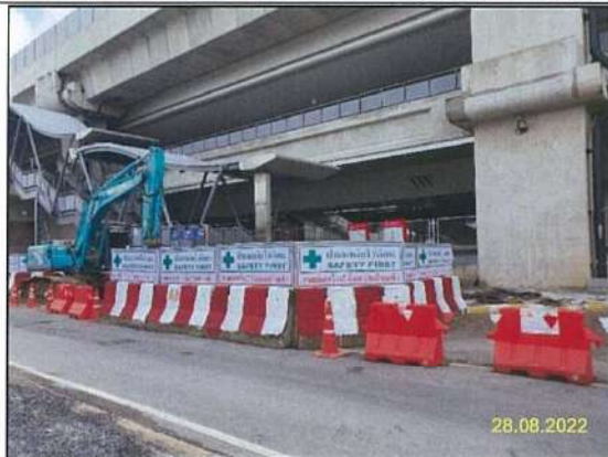
ง) ติดตั้งรั้วกำแพงคอนกรีต (ConcreteBarrier) รอบบ่อรับและบ่อส่ง พร้อมป้ายเตือนเขตหวงห้าม
