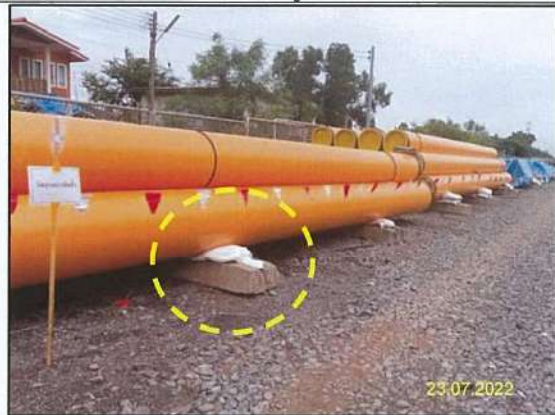
ข) การจัดวางท่อส่งก๊าซฯ และวัสดุป้องกันการพังทลาย
