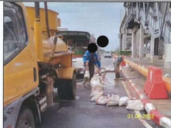
ซ) การจัดเก็บโคลนโซเดียมเบนโทไนท์ที่รั่วไหลขึ้นในบริเวณพื้นที่ใกล้เคียง
