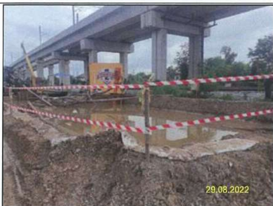
จ) จัดวางถุงทราย และจัดทำคันดินรอบพื้นที่บ่อรับ และบ่อส่ง
