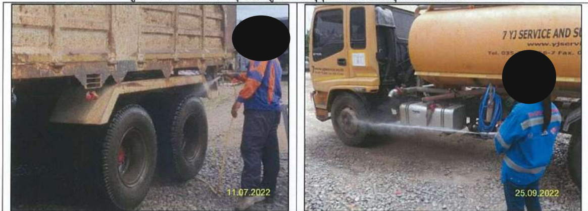
รูปที่ 2-5 การล้างทำความสะอาดเศษดิน และเศษโคลนที่ติดกับล้อรถก่อนออกจากบริเวณพื้นที่ก่อสร้าง
