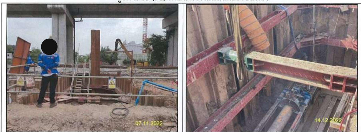
รูปที่ 2-11 การติดตั้ง Sheet Pile เพื่อป้องกันการพังทลายของดิน
